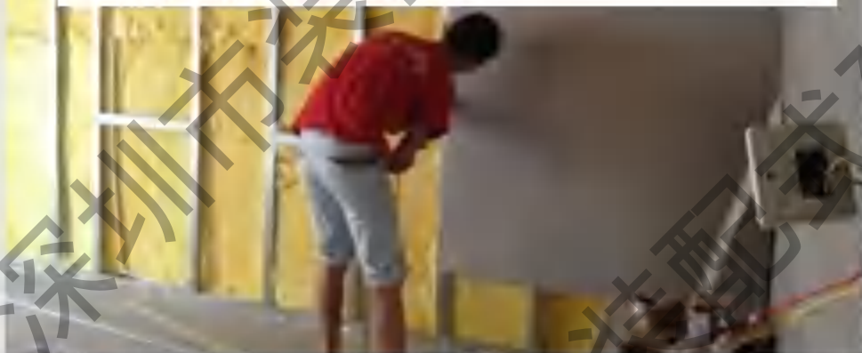
采用主体结构 and 管线分离
