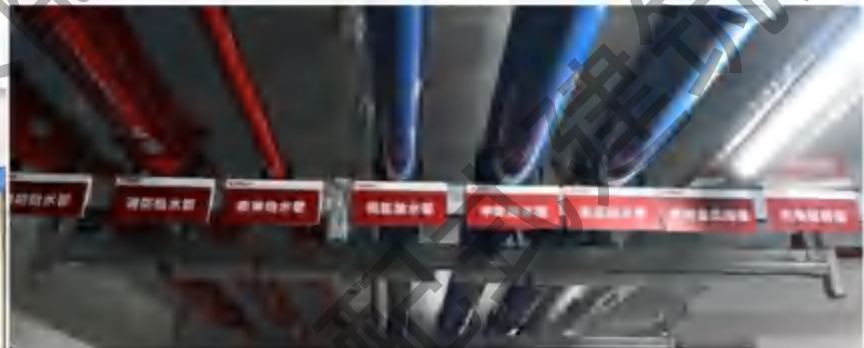
采用主体结构 and 管线分离
